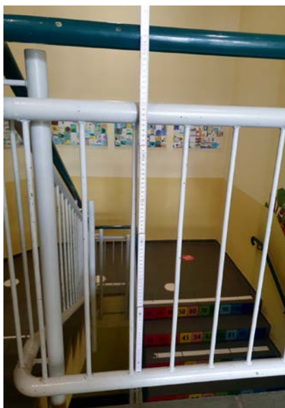
Umwehrung des Treppenbereichs im Obergeschoss einer Grundschule – 0,84 Meter
