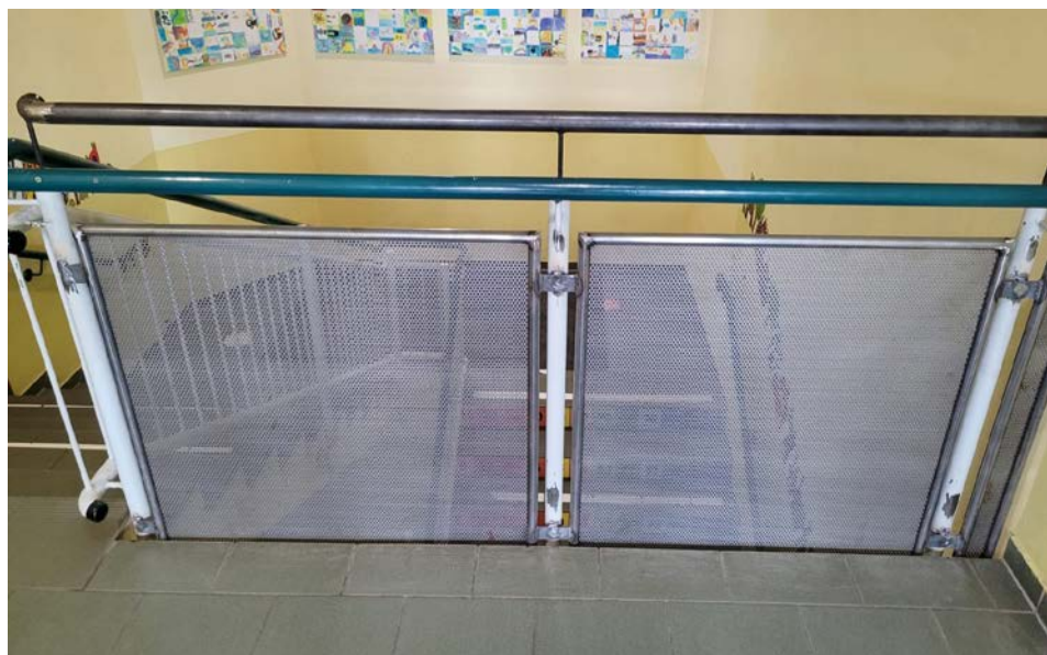
Ersatz der vorhandenen Umwehrung mit Beseitigung der Aufstiegsmöglichkeit und nachträgliche Erhöhung
